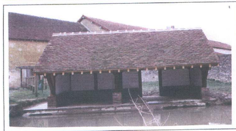
Aspect du Lavoir rénové
