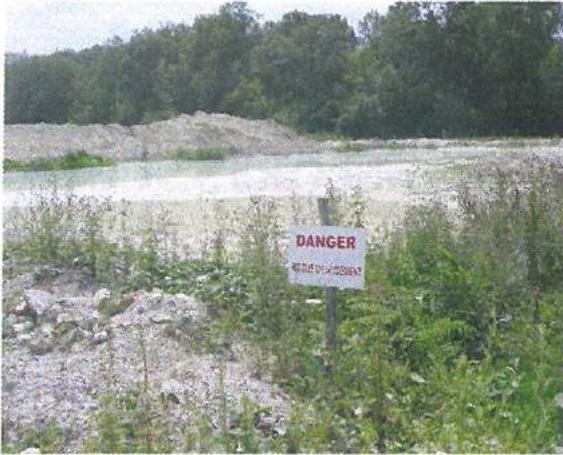
Les bassins de décantation permettent aux particules contenues dans les eaux de sédimenter. Ces particules sont des sables mouvants.
